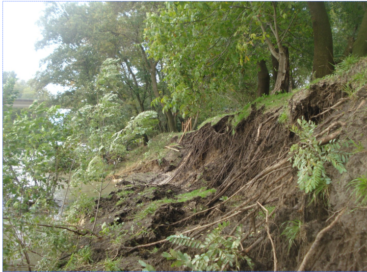
La berge du camping emportée par l'eau
