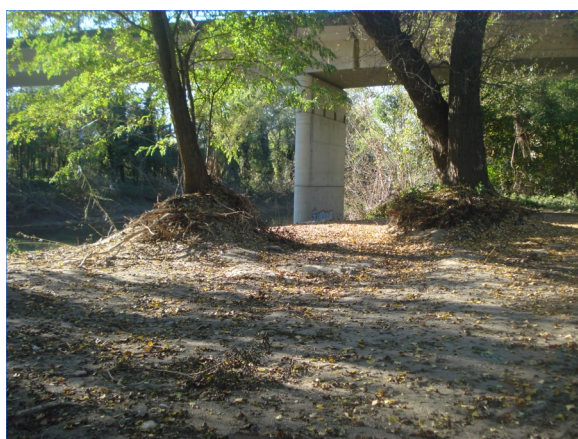
L'espace jeune en cour de travaux
