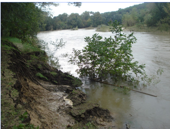
La berge du camping emportée par l'eau
