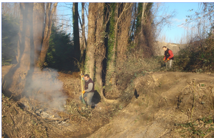
Nettoyage du fossé
